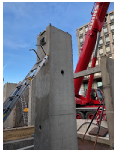
Pelaren monterad på plats
