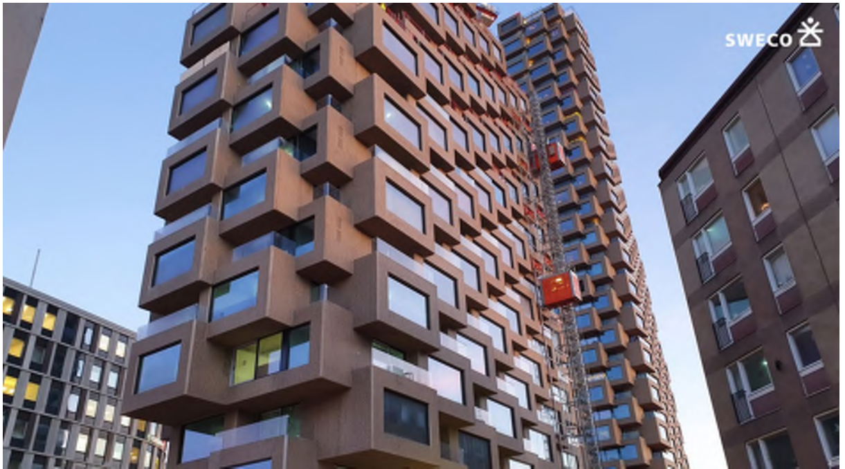
Figur 2 Norra tornen med Innovationen och Helix i förgrunden, foto från SWECO
