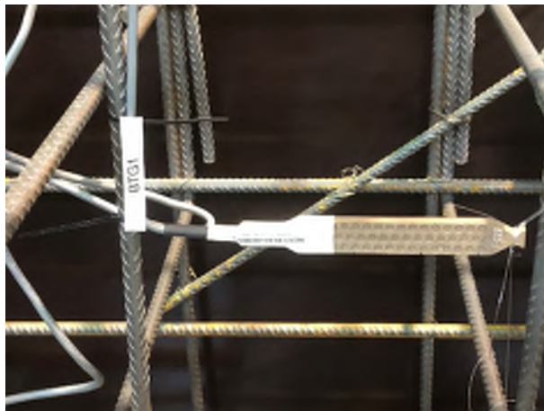
Monterad givare för betong
