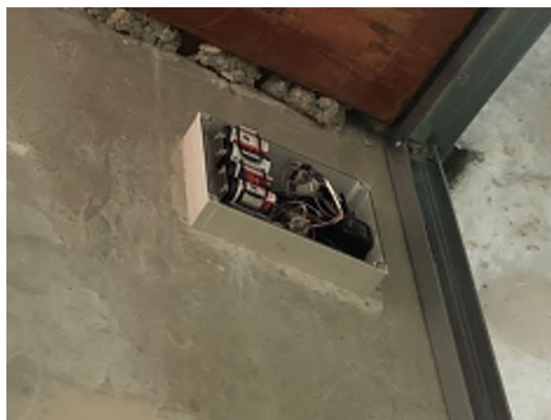
Bortmonterat lock i samband med batteribyte
