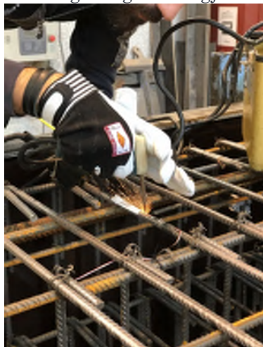
Svetsning av givare på armering
