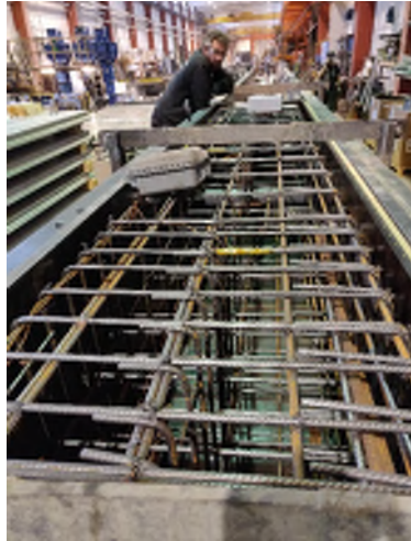
Färdig form innan gjutning
