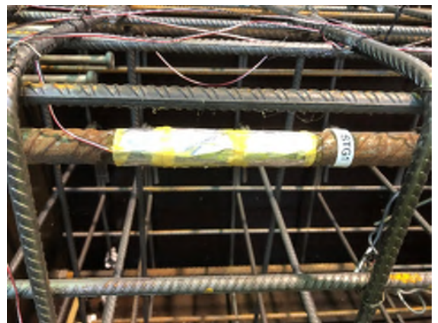
Skyddad givare innan gjutning
