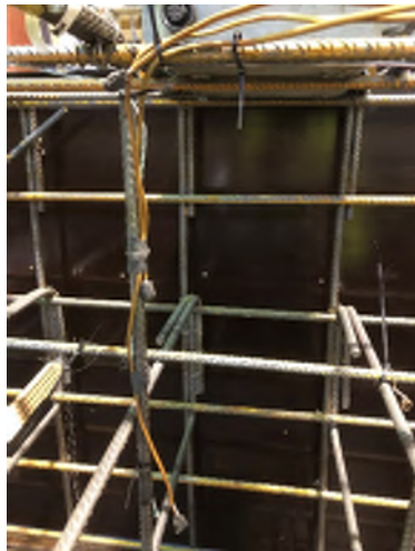
Termoelement för mätning av temperatur under gjutning och det första dygnet, tmp1-tmp3
