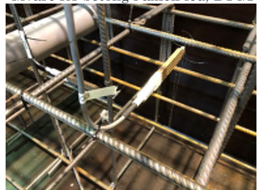
Givare för betong i tvärlid, BTG3
