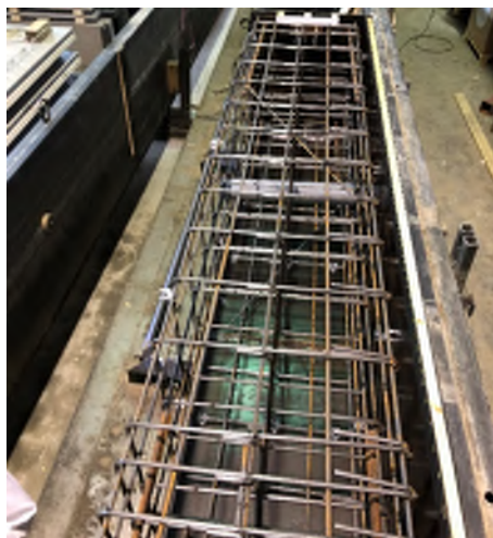
Armeringskorg innan gjutning
