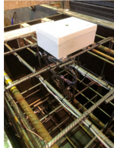
Placering av låda för insamling av data. Observera också kabeldragningen under lådan. Samtliga kablar går in i baksidan. Lådan är IP68 klassad. I mitten syns också grön/vitt termoelement
