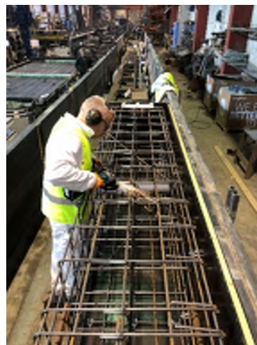
Slipning av armering innan givar montage
