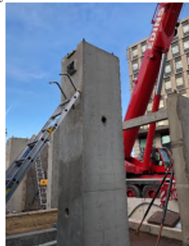
Pelaren monterad på plats
