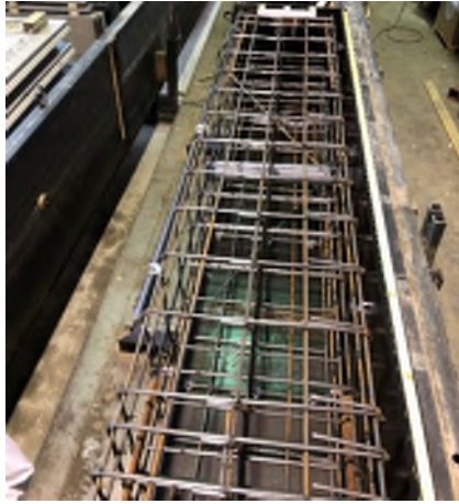
Armeringskorg innan gjutning
